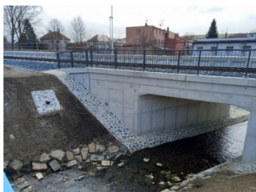
Obr. 1b Část žel. tratě s mostem
